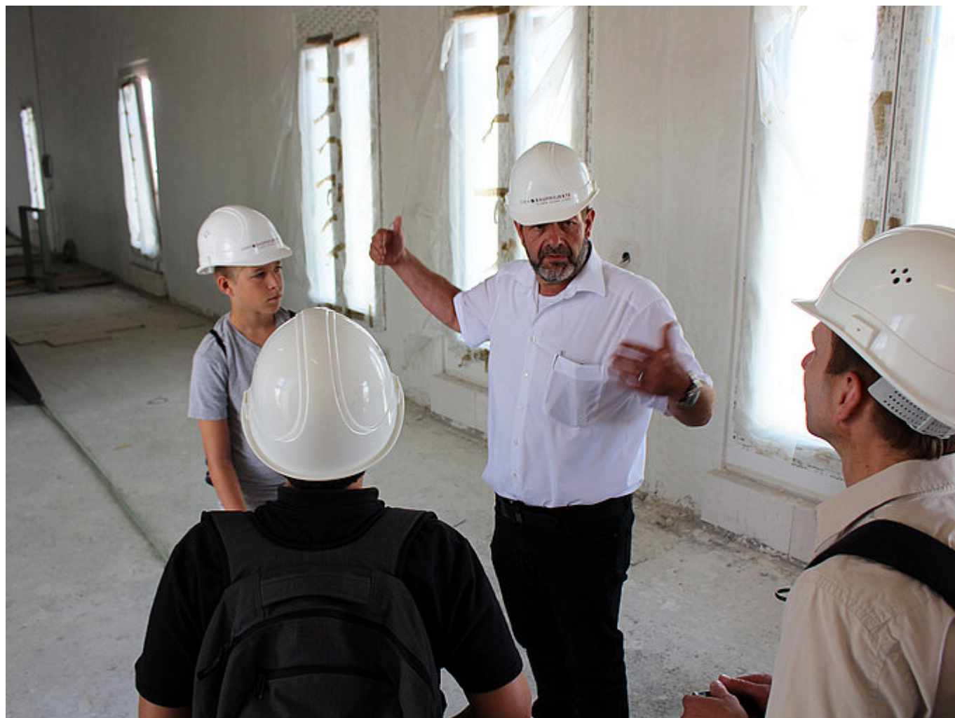
Projektleiter Manfred Martin erklärt die kommenden Bauschritte.
