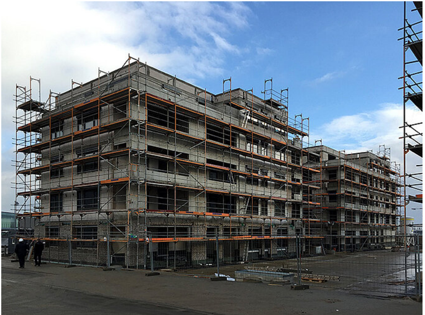
Rohbau am GWH Riedberg 2.0
