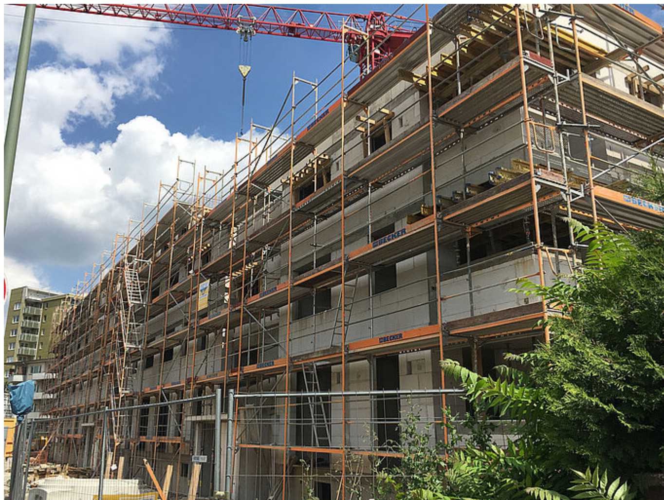
Der Rohbau des Gebäudes in der Rhönstraße ...
