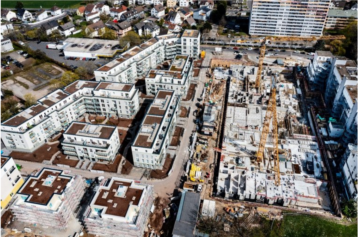
Luftbild Grundstück während der Bauphase
