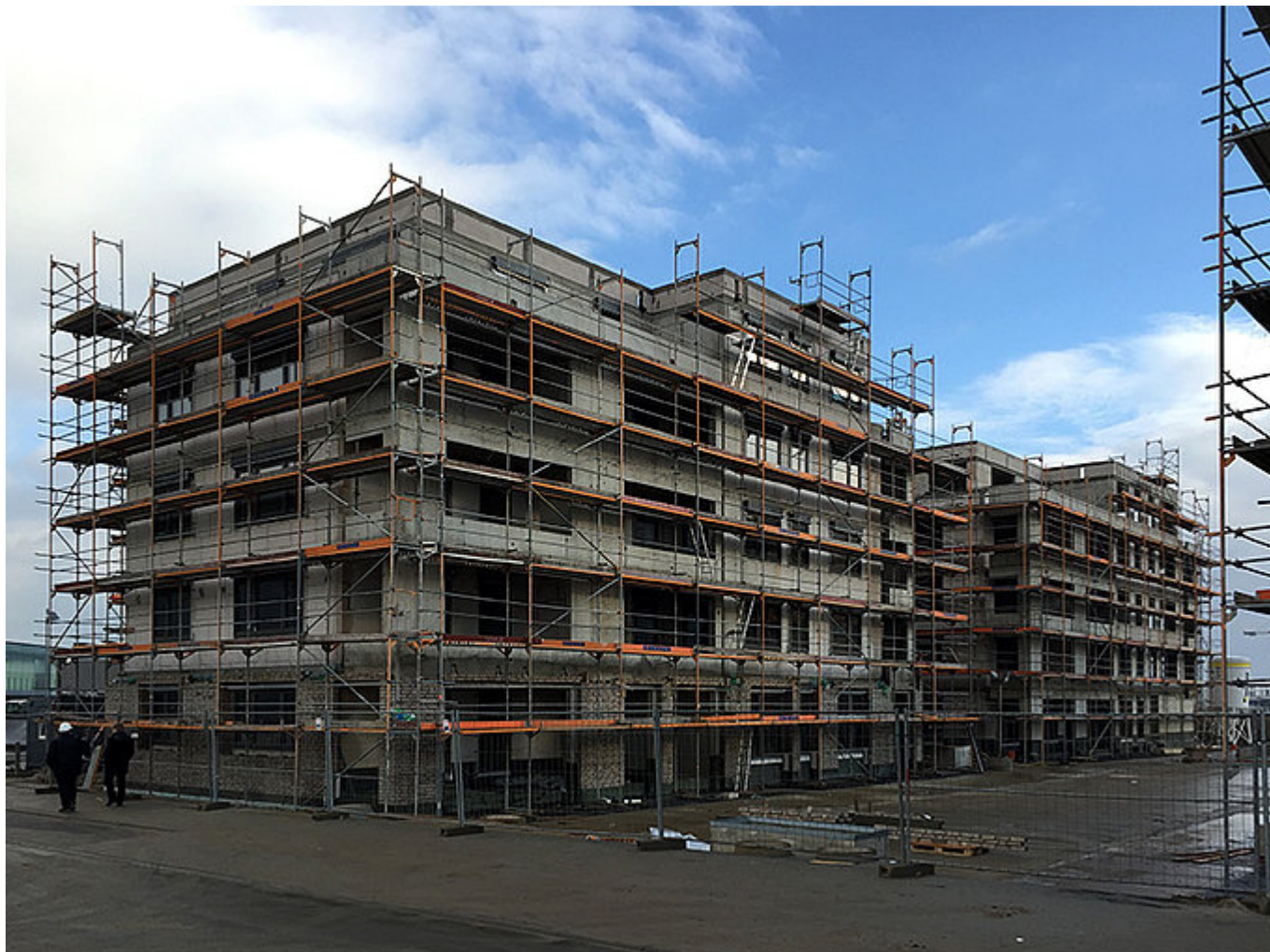
Rohbau am GWH Riedberg 2.0
