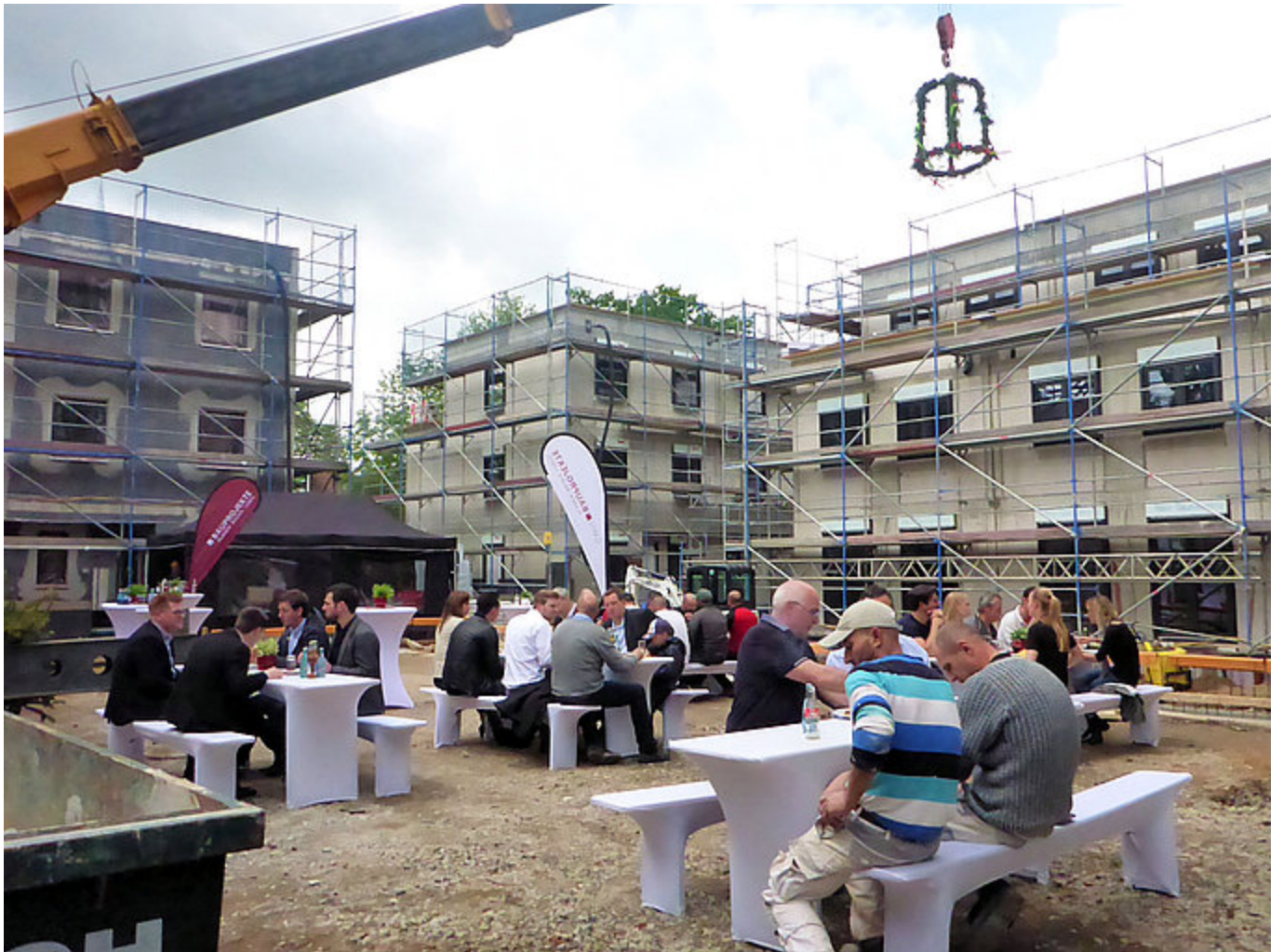
Bei kühlen Getränken und einem Grillbuffet feierten alle Projektbeteiligten die Fertigstellung des Rohbaus.
