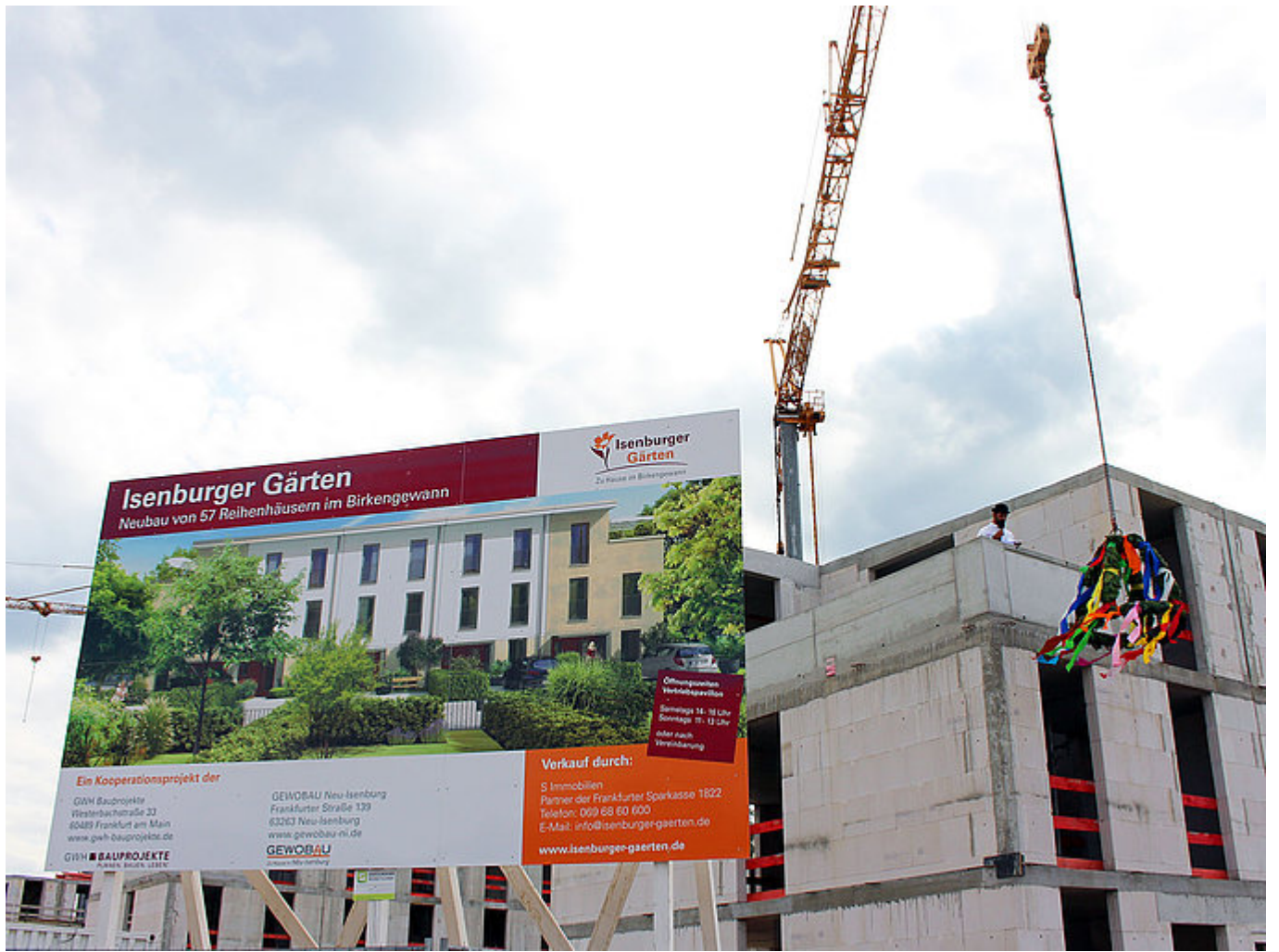
Bauleiter Ibrahim Cevahir beim traditionellen Richtspruch.
