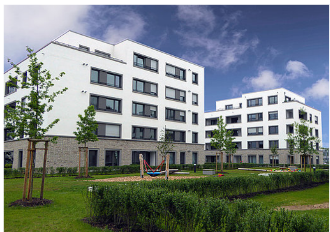
Frankfurt: GWH Riedberg 2.0 Eigentumswohnungen
