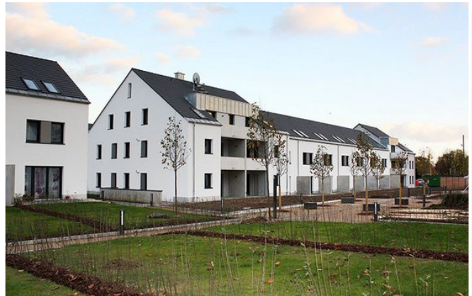
Frankfurt: GWH-Parkstadt Mietwohnungen und -reihenhäuser
