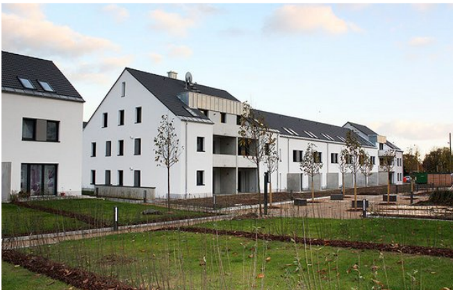
Frankfurt: GWH-Parkstadt Mietwohnungen und -reihenhäuser
